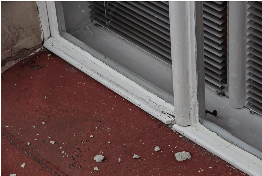
55. Poškozený nátěr okenní výplně spodní okapnice a vlýsu křídla.
