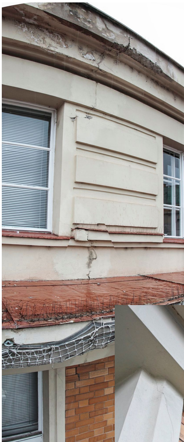
35. Dilatační a statická porucha zhruba v polovině délky jižního průčelí budovy s trhlinou procházející od koruny zdiva až po nadpraží okna v přízemí. Na snímku průběh trhliny po výšce 4. NP.
