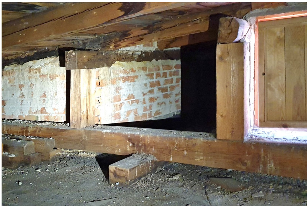
63. Pohled do půdního prostoru střechy nad dvoupatrovou částí na JZ nároží se zděnými boky prosklených světlíků, vpravo dřevěný vstup do světlíku.
