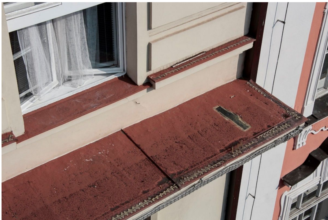
21. Poškození původního oplechování z ocelového pozinkovaného plechu na římsě nad 3. NP.
