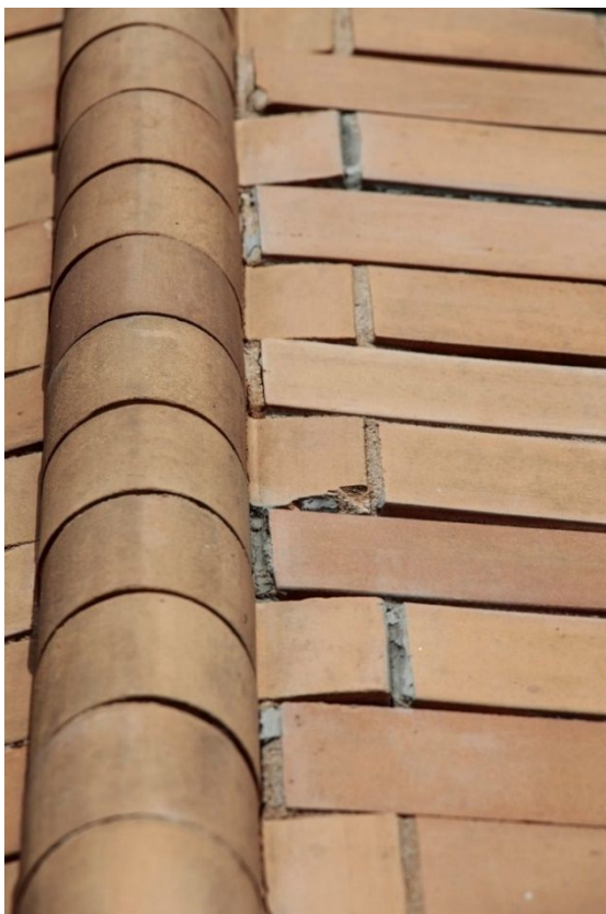
29. Detail styku polosloupku keramických tvarovek s plochou keramických obkladů. Patrně je poškození spárovací malty a oprava nevhodnou jemnozrnnou cementovou maltou.
