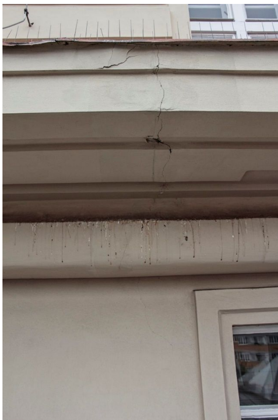
38. Přirozená dilatační trhlina v železobetonové římsě nad 3. NP s destrukcí omítky v okolí trhliny.
