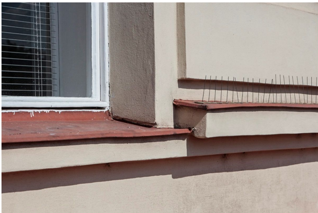
54. Detail oplechování okenního parapetu.
