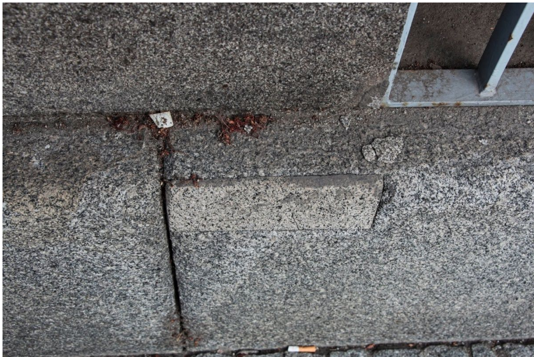
25. Starší oprava vysazením mechanicky poškozené části žulového kvádru. Chybějící spárovací malta.
