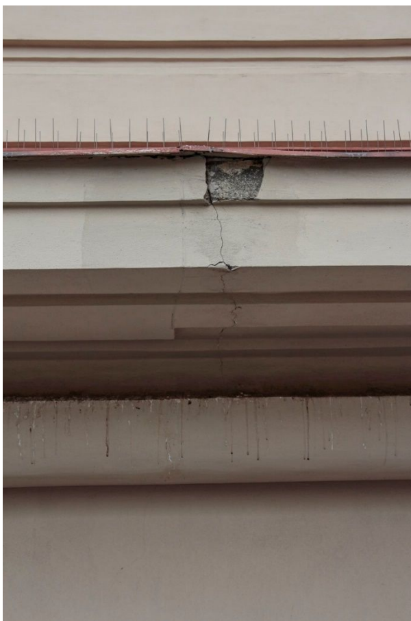
39. Přirozená dilatační trhlinka v železobetonové římsě s destrukcí omítky v okolí trhliny.
