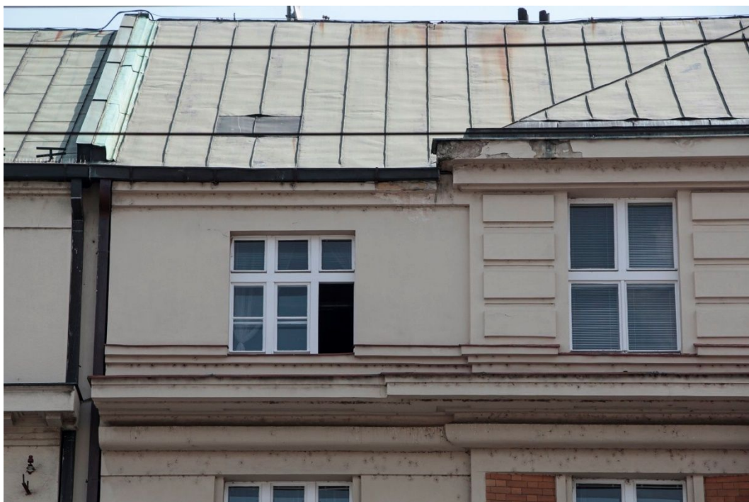
16. Následky zatékání do římsy poškozeným nástřešním žlabem na nároží západního průčelí.
