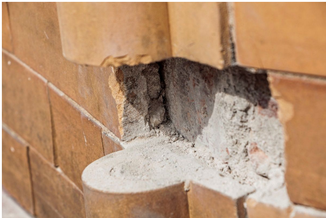
34. Na boku sondy je patrné výrazné odloučení keramického obkladu a lepicí malty od zdiva se vznikem několikamilimetrové spáry. Lepicí malta je rozdrobená.
