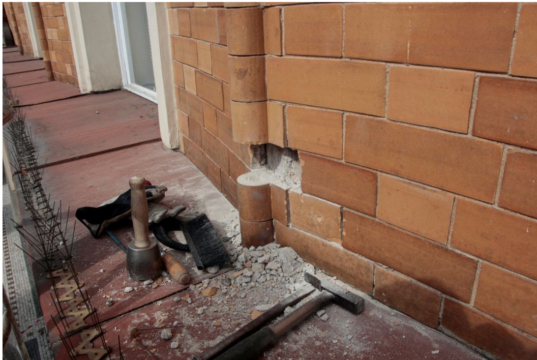
33. Sonda do skladby keramického obkladu a odběr materiálu pro vyhledání vhodného výrobce kopie původních keramických prvků
