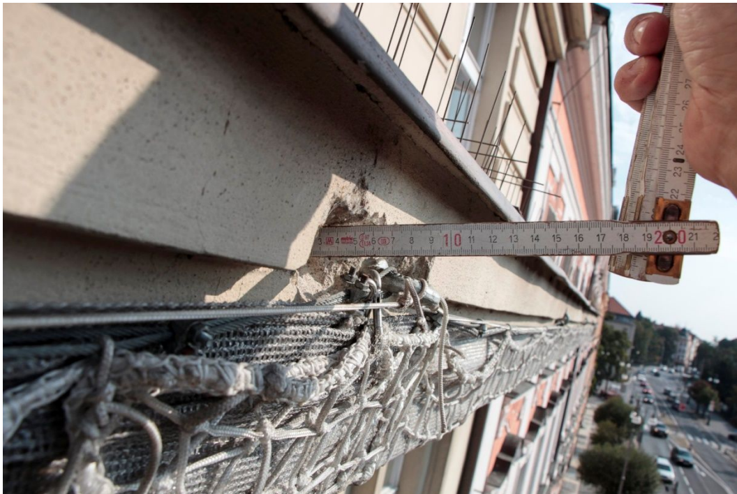
41. Značná tloušťka omítky (5 cm) na čele železobetonové římsy. Havarijní omítka na podhledu římsy je zajištěna proti pádu ukotvenou sítí.
