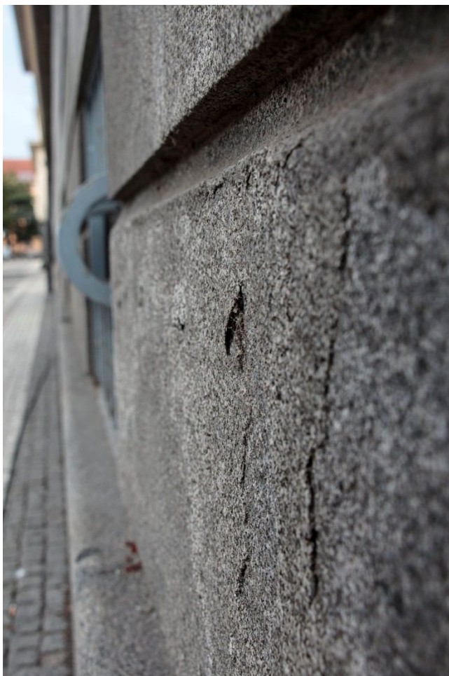
23. Vysoký sokl z žulových kvádrů. Asi do poloviny výšky je patrné poškození a změna odstínu kamene způsobené zasolením, vyšší vlhkostí a destrukcí povrchové vrstvy
