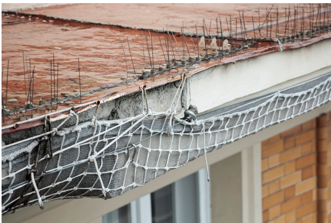
22. Detail zhoršeného stavu původního oplechování z ocelového pozinkovaného plechu a záchytná síť zabráňující pádu poškozené omítky.
