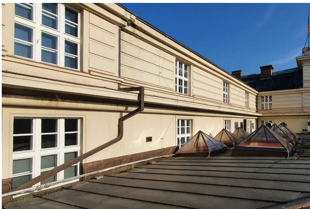
62. Dodatečně upravený dešťový svod, esteticky nevhodně obíhající hlavní římsu nad 3. NP budovy.
