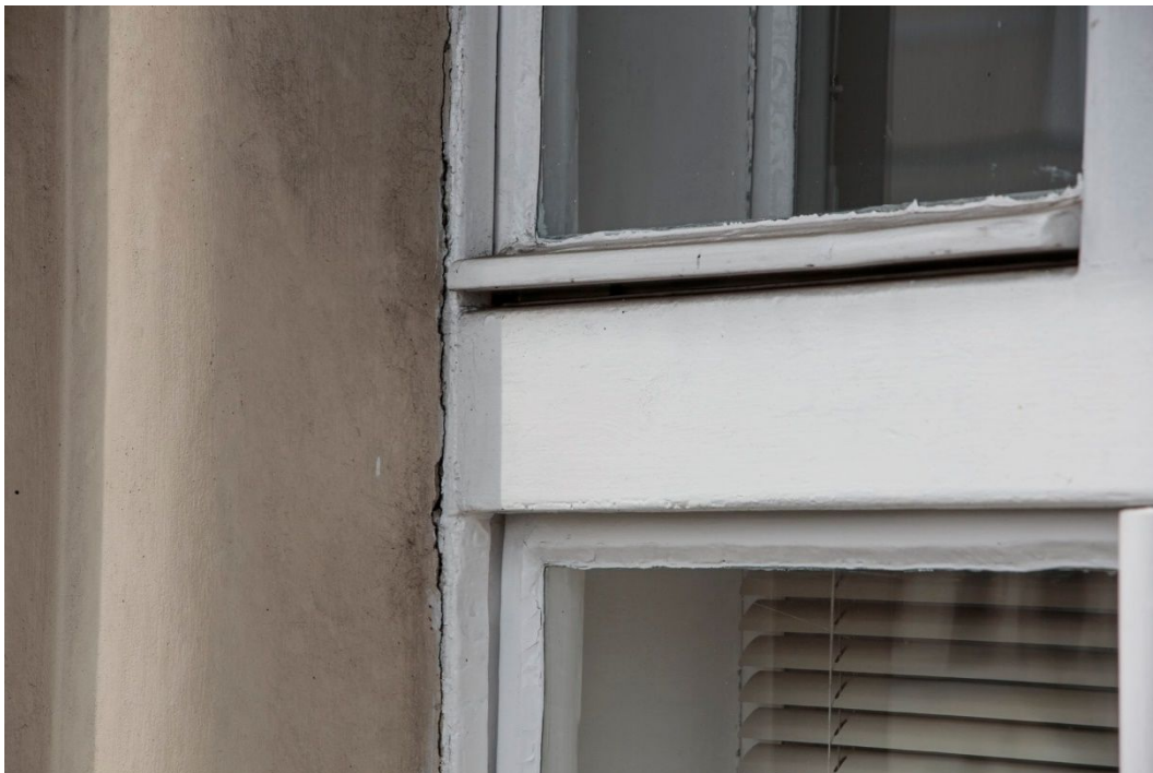
51. Detail styku okenního rámu a omítky ostění.
