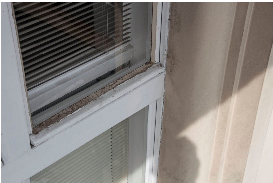
52. Necelistvý nátěr okenní výplně po výměně skleněné tabule.
