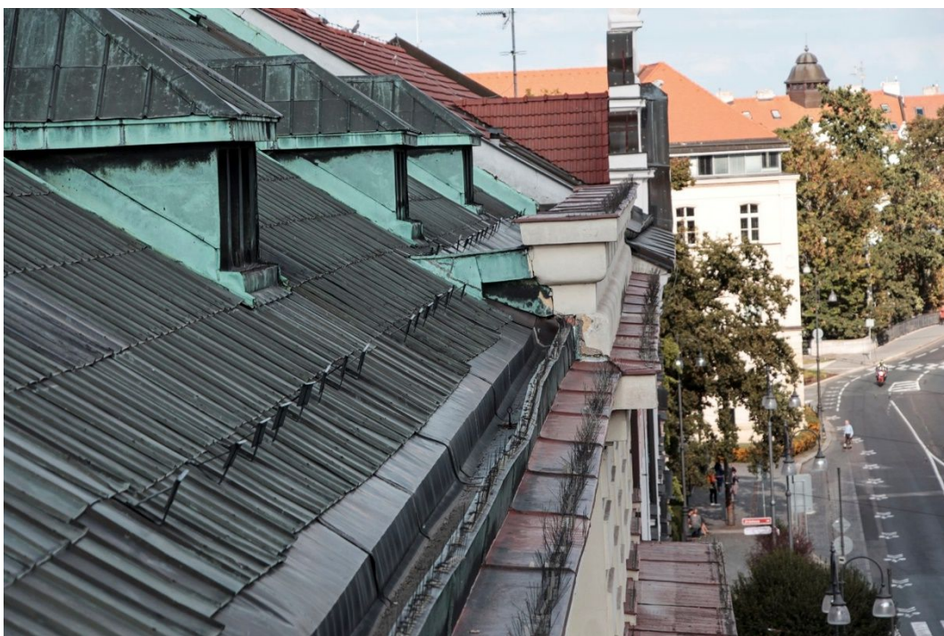
20. Deformace nástřešního žlabu zamrznutím vody. Vzadu na snímku atika východní koncové části průčelí.
