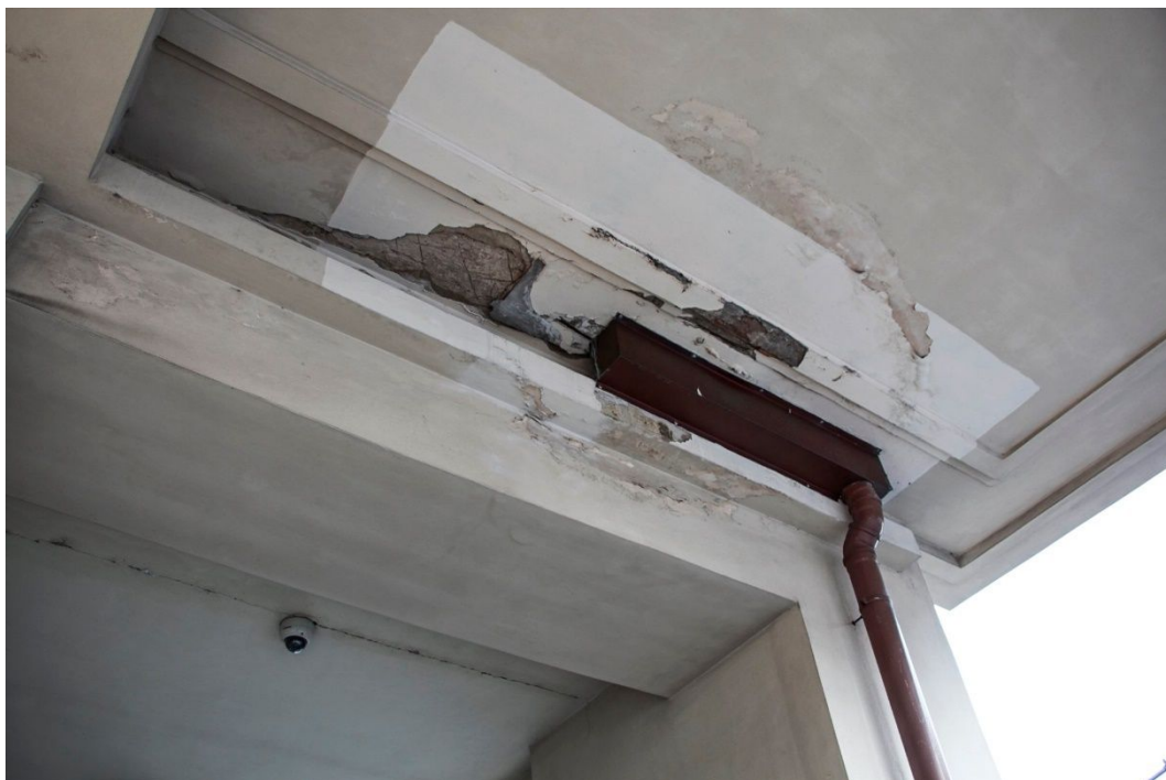
15. Následky zatékání do stropních omítek ve vstupním portiku poškozeným dešťovým svodem.
