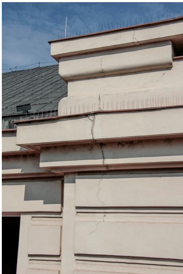
37. Dilatační a statická porucha ve zdivu východní koncové části budovy.
