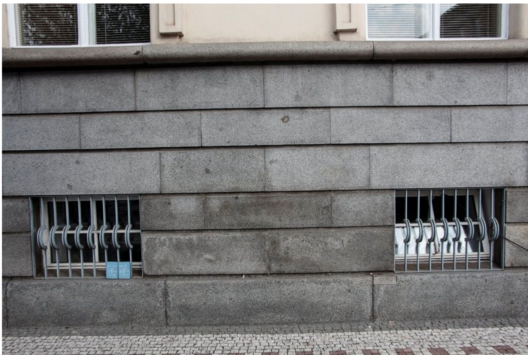
23. Vysoký sokl z žulových kvádrů. Asi do poloviny výšky je patrné poškození a změna odstínu kamene způsobené zasolením, vyšší vlhkostí a destrukcí povrchové vrstvy
