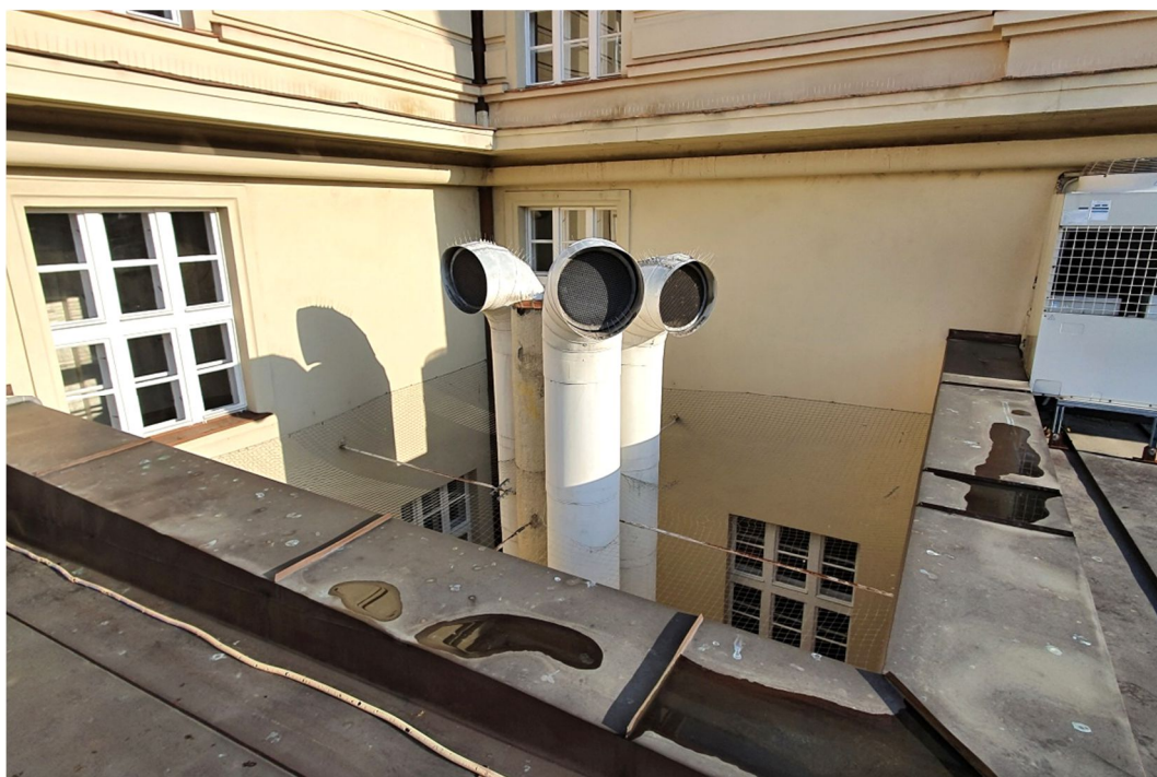
65. Vyústění vzduchotechniky ze sklepa uvnitř vnitřního světlíku mezi křídly budovy.
