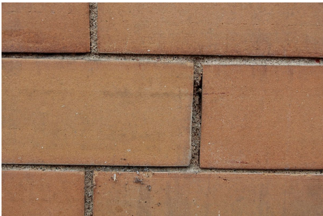
32. Značně hrubozrnná původní spárovací malta z hydraulického vápna, z větší části kompenzující dilatační pohyby keramických pásků. Část spárovací malty je degradovaná a vypadlá ze spáry.
