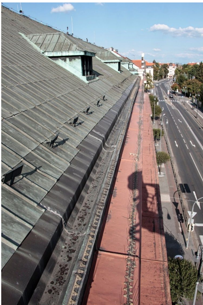
19. Provedení nástřešního žlabu a navazující střechy na jižním průčelí.
