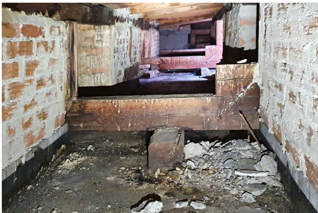
64. Pohled do půdního prostoru střechy nad dvoupatrovou částí na JZ nároží se zděnými boky prosklených světlíků.
