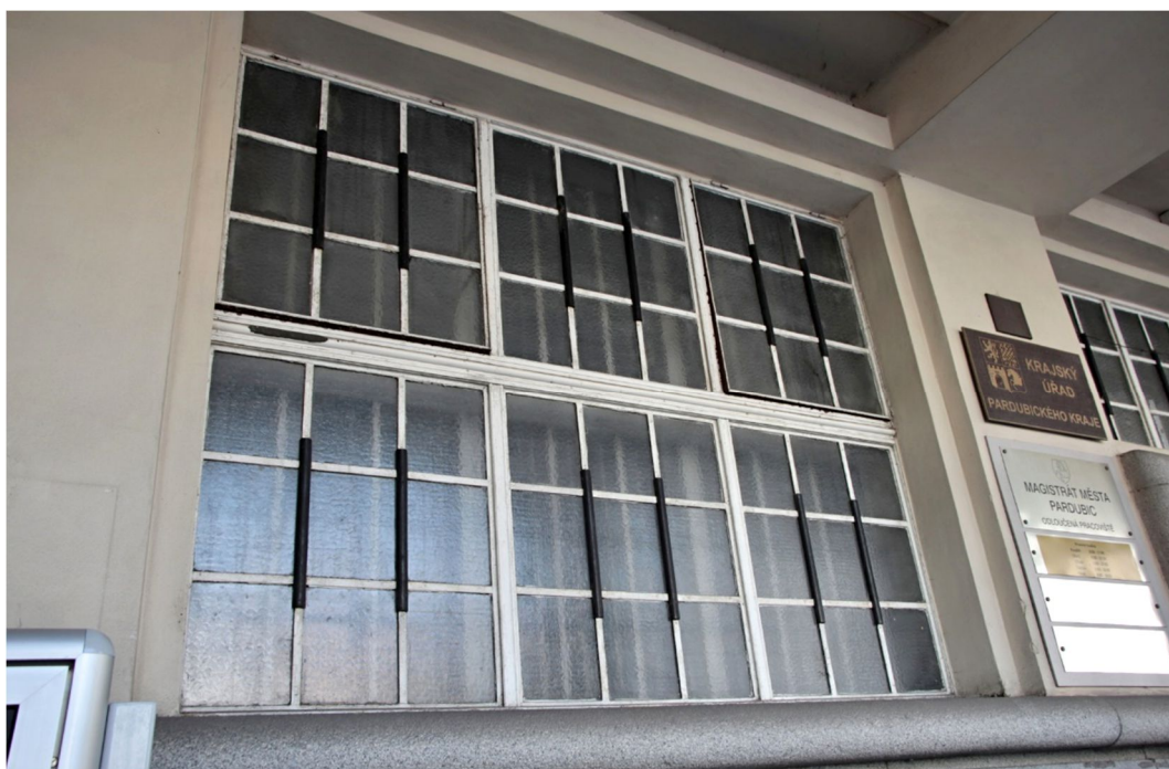
58. Ocelové okno vedle hlavních vchodových dveří pod portikem.
