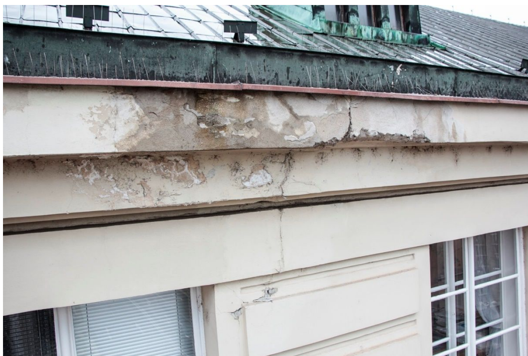
17. Následky zatékání do římsy poškozeným nástřešním žlabem v místě dilatační a statické poruchy.
