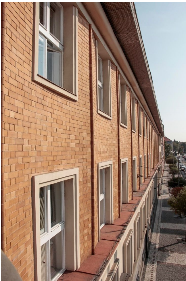
27. Boční pohled na prohnuté plochy fasádních polí ve 2. a 3. NP obložené keramickými taženými pásky.
