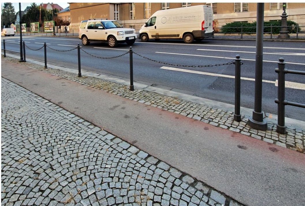
60. Demontovatelná část zábradlí mezi ulicí a chodníkem před sousedním domem čp. 127, která bude využita v průběhu stavby pro přístup na pomocnou staveništní plochu.
