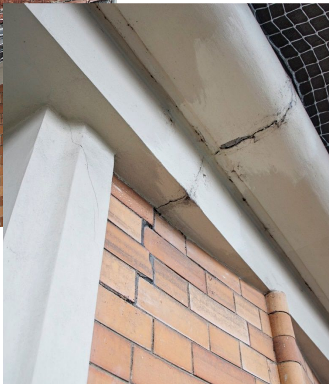
36. Detail trhliny z předchozího snímku v římsě nad 3. NP, procházející přes obklad do okenního otvoru.
