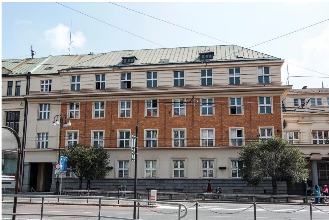
12. Čtyřpodlažní část západní fasády s keramickým obkladem.
