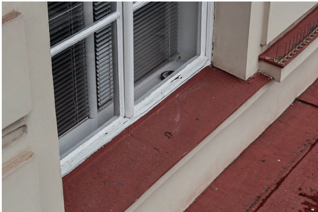
53. Poškozený nátěr okenní výplně spodní okapnice a vlysu křídla.
