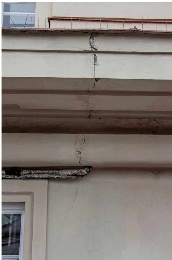
40. Přirozená dilatační trhlinka v železobetonové římsě s destrukcí omítky v okolí trhliny.
