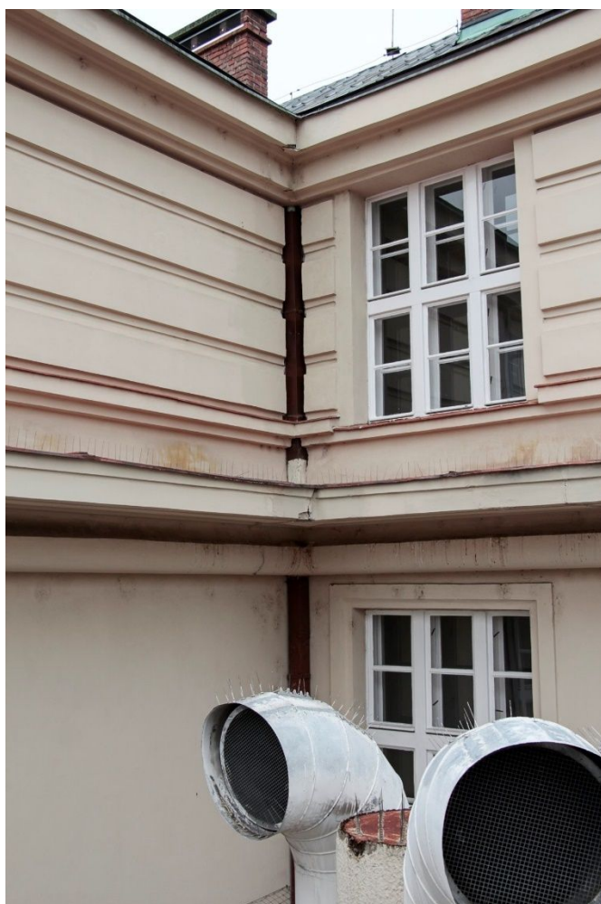
17. Následky zatékání do římsy poškozeným nástřešním žlabem v místě dilatační a statické poruchy.
