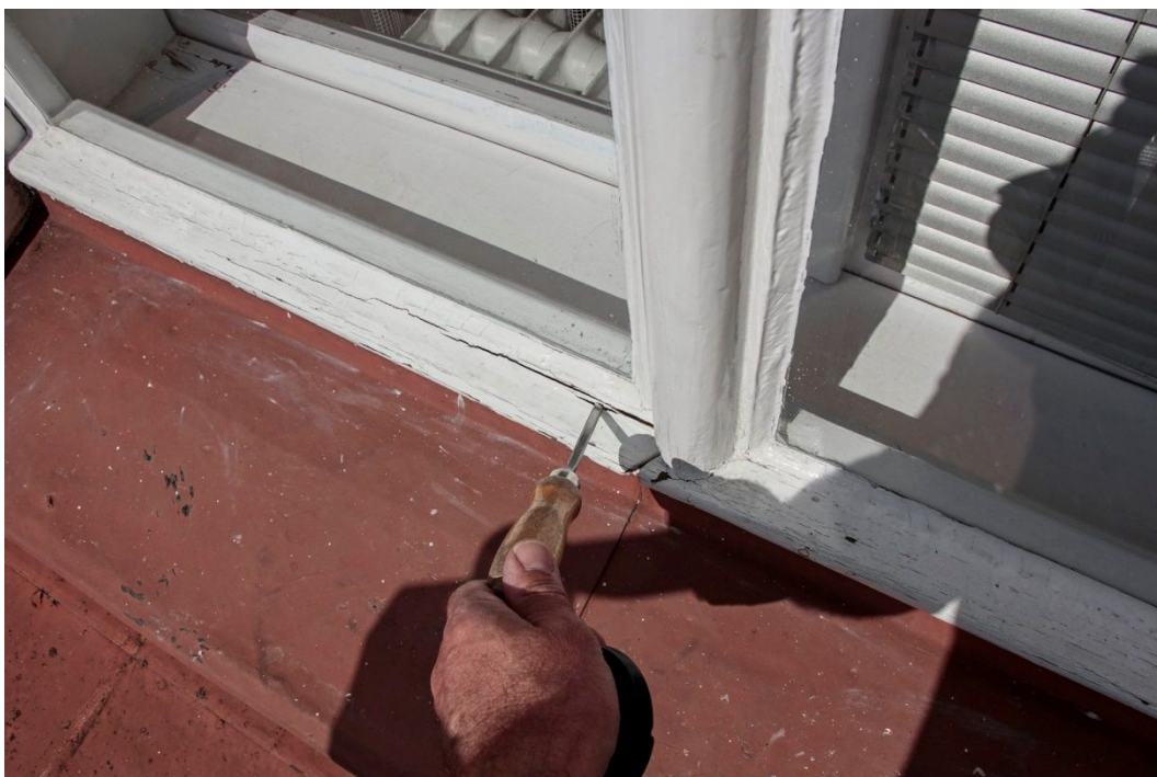
56. Spodní dřevěná okapnice poškozená hnilobou.
